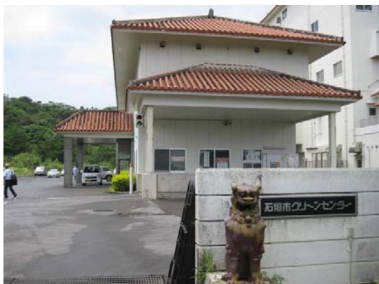
石垣市クリーンセンター
