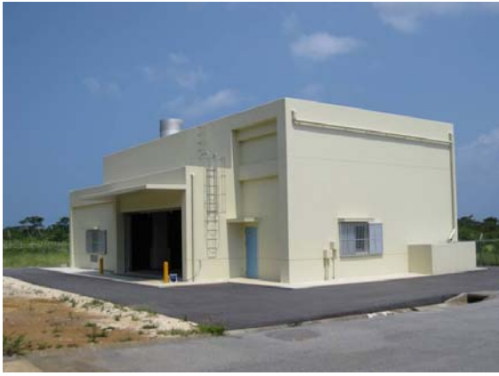
西表島の焼却施設（建屋）
