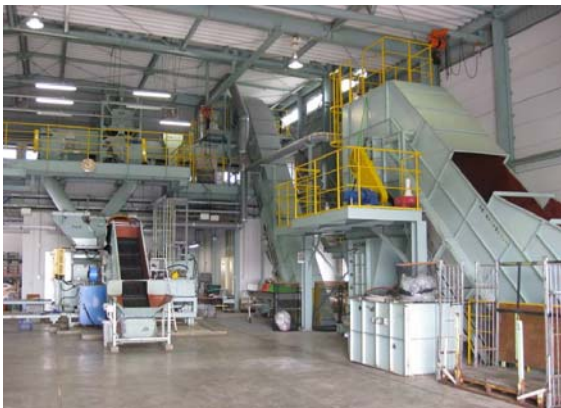
リサイクルセンター内部
