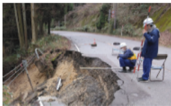
危険箇所での被災状況調査
