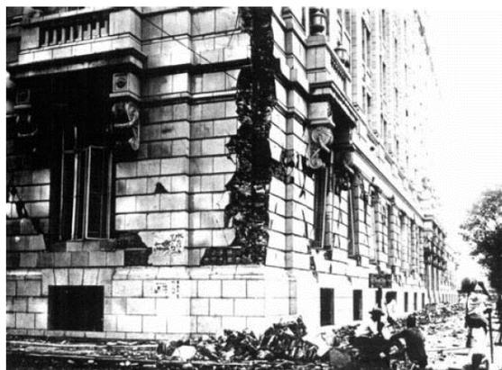
郵船ビル（1923年5月竣工、壁が損傷）
