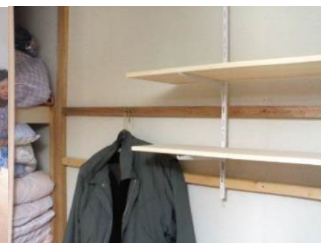
仮設住宅への棚の設置
